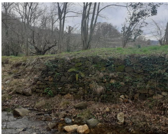
Ancienne protection de berge en aval du site qui limite les capacités d'auto-ajustement du cours d'eau
