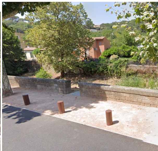
Figure 25 : Exemple de discontinuités observées sur les murs installés en crête de berge
