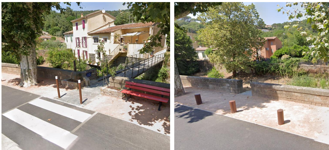
Figure 19 : Exemple de discontinuités observées sur les murs installés en crête de berge
