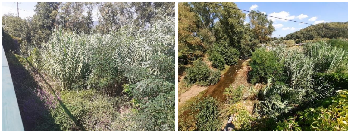
Figure 2 : (Gauche) Aval Pont ; (Droite) Amont pont. Photo prise en septembre 2021
