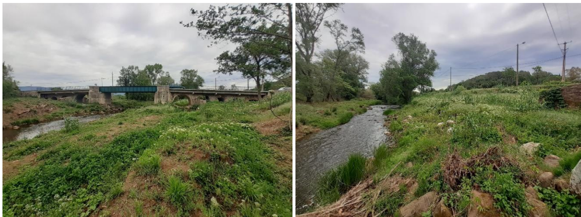
Figure 3 : (Gauche) Aval Pont ; (Droite) Amont pont. Photo prise en mai 2022
