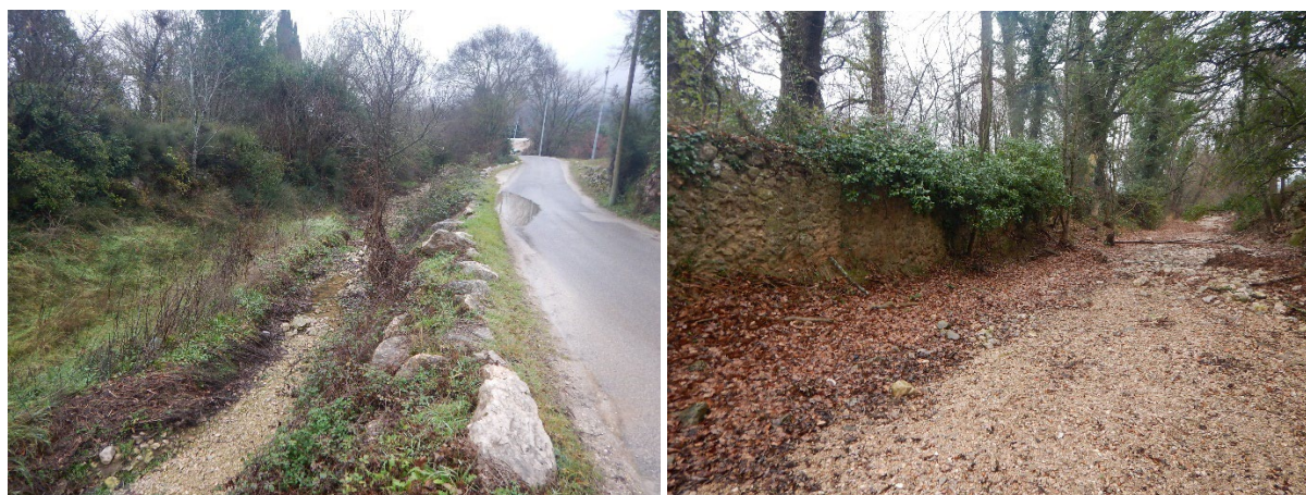
Enrochement du Latay en rive droite au droit d'une voirie, et mur en berge rive gauche (retrouvé sur les deux rives sur la majeure partie du linéaire de cette zone)
