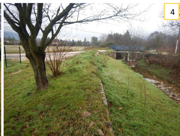
1 : Blocs sur le merlon rive gauche - partie amont des Ferrages ; 2 : Variété des protections du merlon rive gauche (disposées en urgence entre les deux crues de 2019) ; 3 : Muret en tête de merlon rive gauche ; 4 : Fin du muret en tête de merlon au droit du chemin de la Limatte
