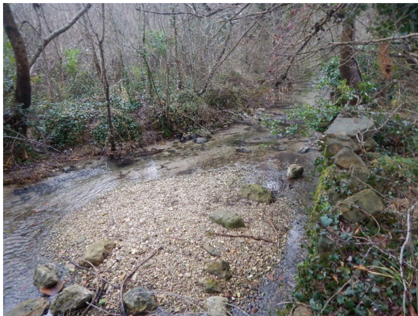
Atterrissement et radier à l'aval du moulin
