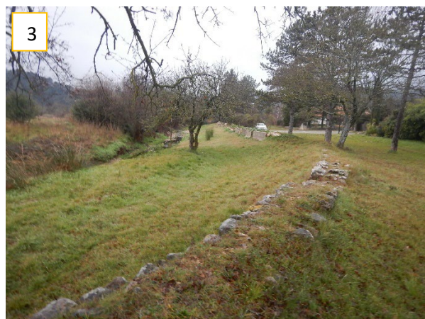
1 : Blocs sur le merlon rive gauche - partie amont des Ferrages ; 2 : Variété des protections du merlon rive gauche (disposées en urgence entre les deux crues de 2019) ; 3 : Muret en tête de merlon rive gauche ; 4 : Fin du muret en tête de merlon au droit du chemin de la Limatte
