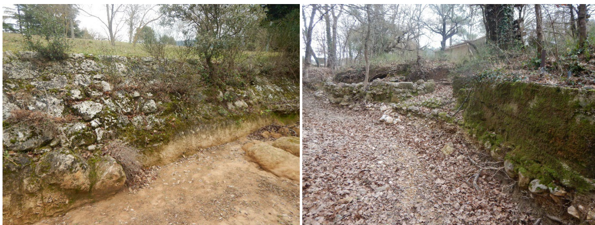
Protections de berge sur la Latay, Zone 1
