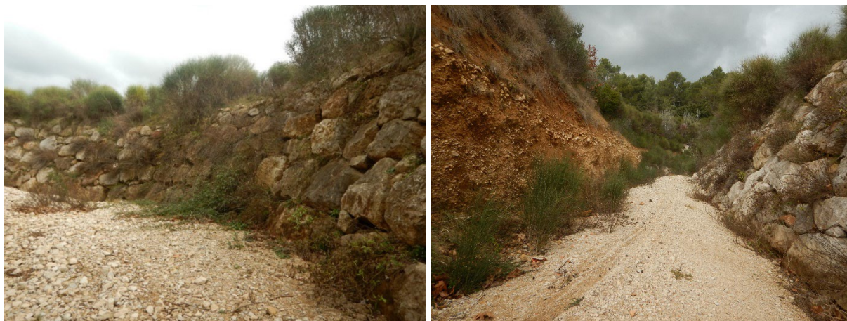
Enrochements, rive droite du Latay, au droit de la carrière
