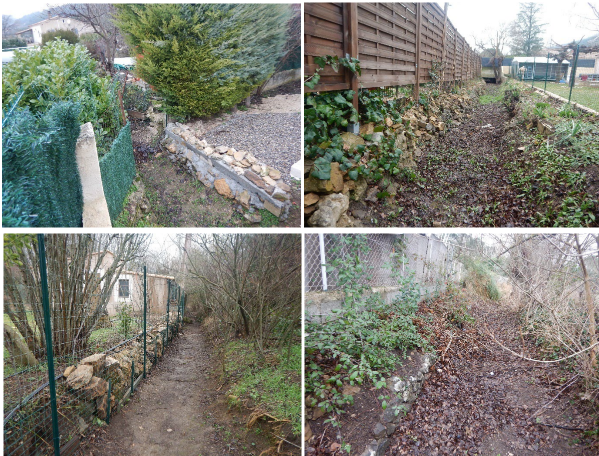
Protections de berges dans le lotissement des Launes
