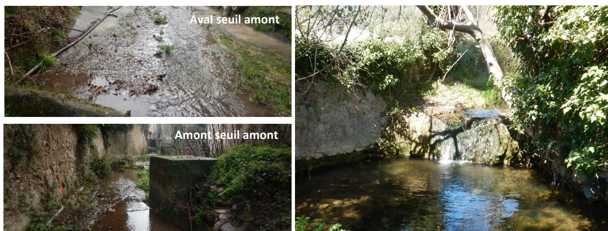
Seuils à l'amont de la couverture et seuil sur la partie terminale du Raby
