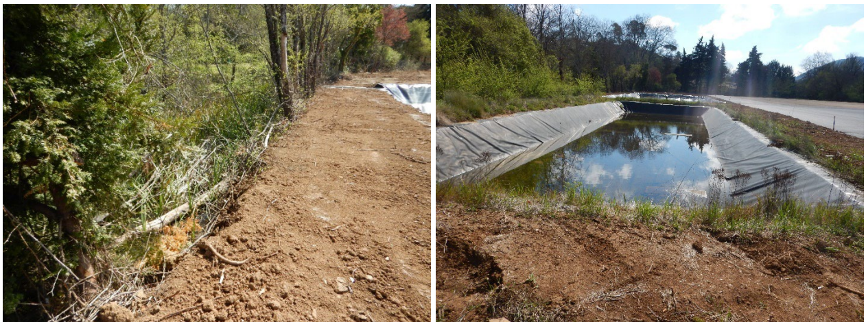
Figure 47 : Berge rive droite du Gapeau au droit de l'usine Beaupré (Avril 2021)
