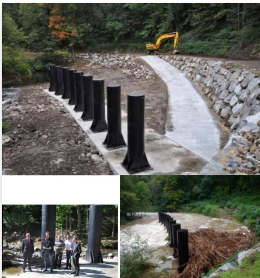
*Figure 27 : Exemple de piège à embâcles construit sur la Deûme– Source : mairie d'Annonay*
