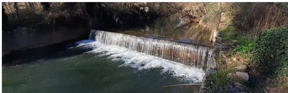
Seuil du Pourret situé à l'aval du périmètre d'étude imposant un remous solide et liquide (ROE45642)
