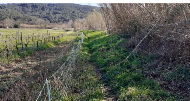
Digue en remblais en rive gauche dans la plaine agricole au droit de la STEP – présence de canne de Provence
