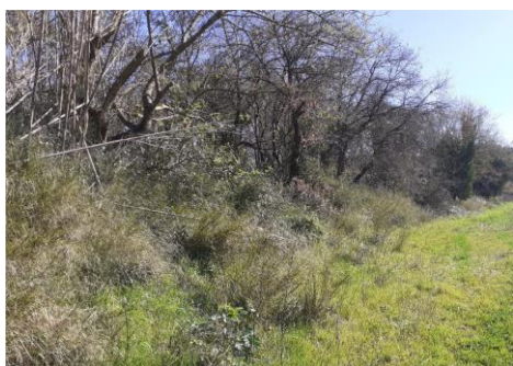
Digue en remblais en rive droite à l'aval de la confluence avec le Meige Pan
