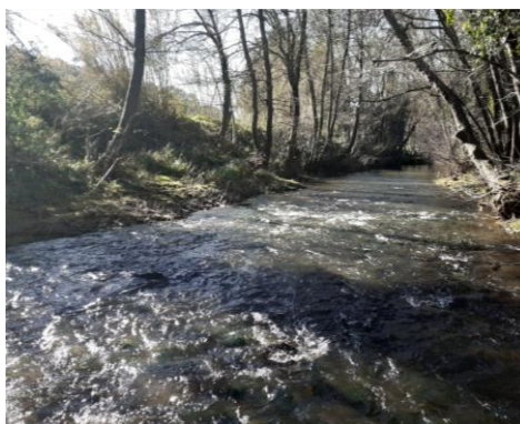
Sur-calibrage du lit du Réal Martin en amont de la traversée de la RD14
