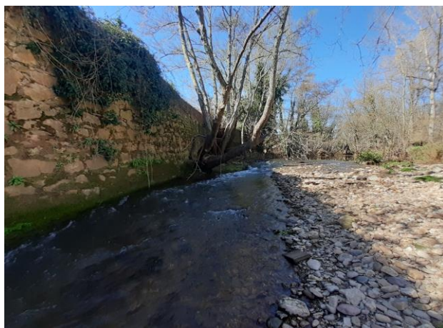
Mur de la berge rive droite de la gravière
