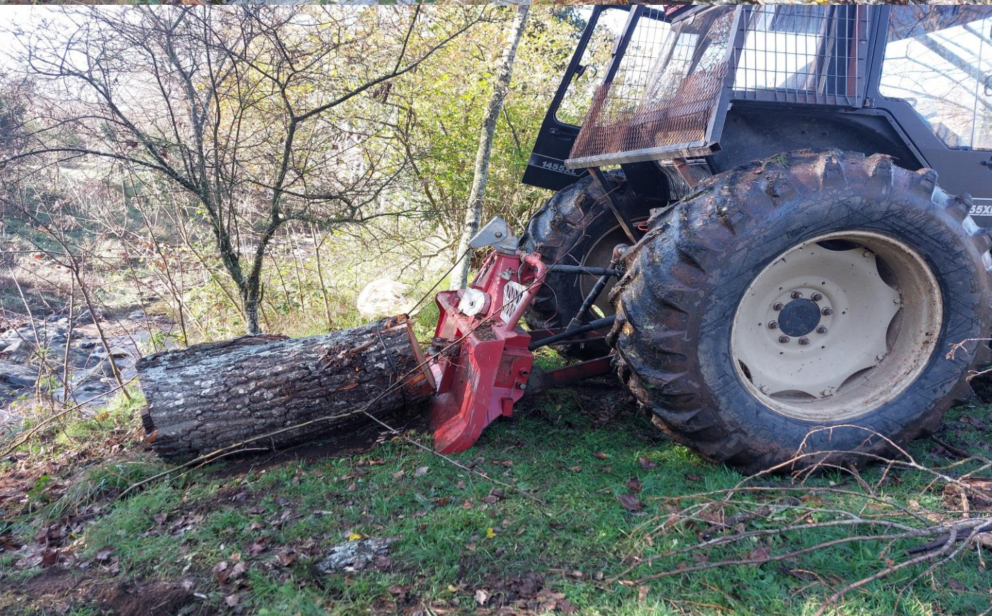
Photo @S.M.B.V.G. Travaux d'entretien des cours d'eau
