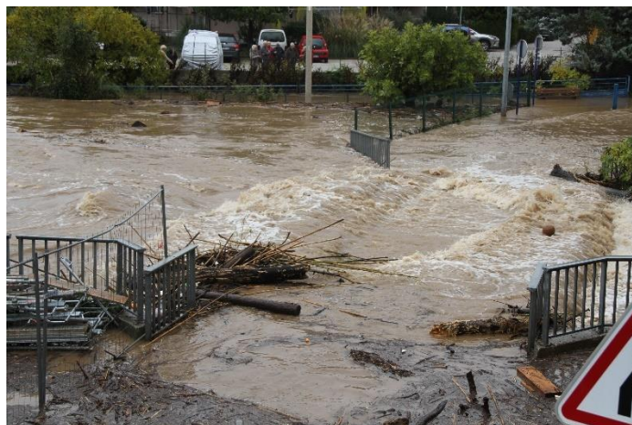
Figure 9 : Pont de la salle des fêtes lors de la crue de 2019
