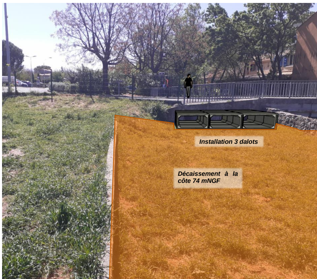
Figure 8 : Emplacement des dalots béton
