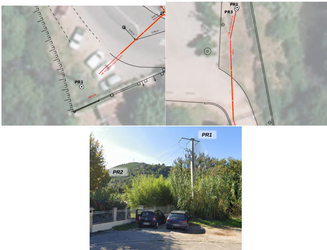
Figure 15 : Emplacement des deux poteaux HTA
