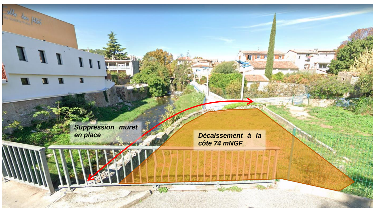
Figure 7 : Travaux à réaliser en amont des dalots
