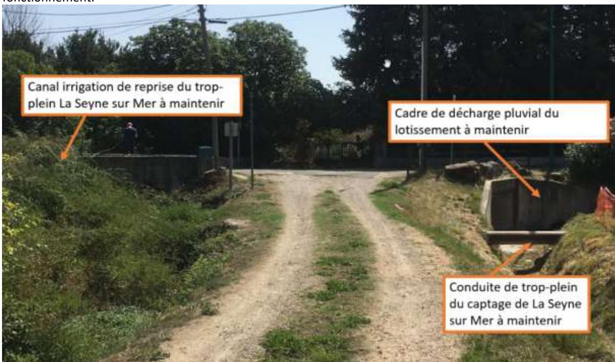
Figure 5. 38 – Reprise du radier du seuil et ouvrages à maintenir
