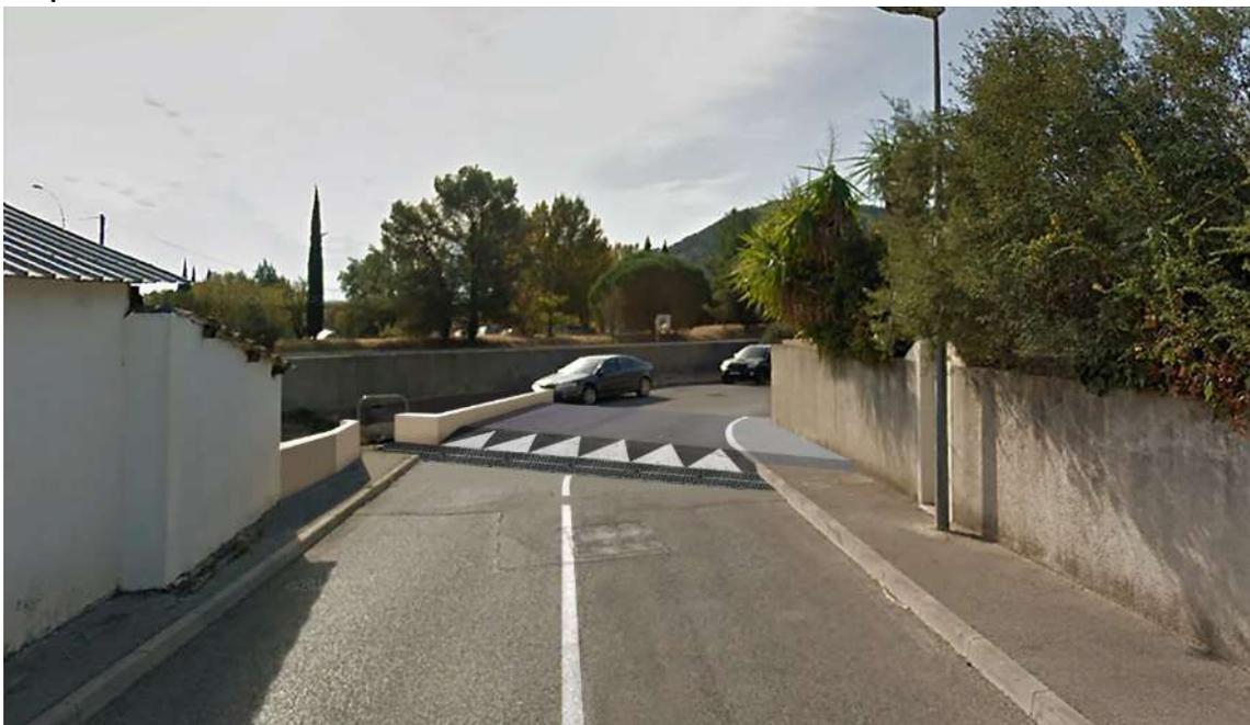
Figure 5. 26 – Aménagement d’un ralentisseur pour rediriger les écoulements vers le répartiteur
