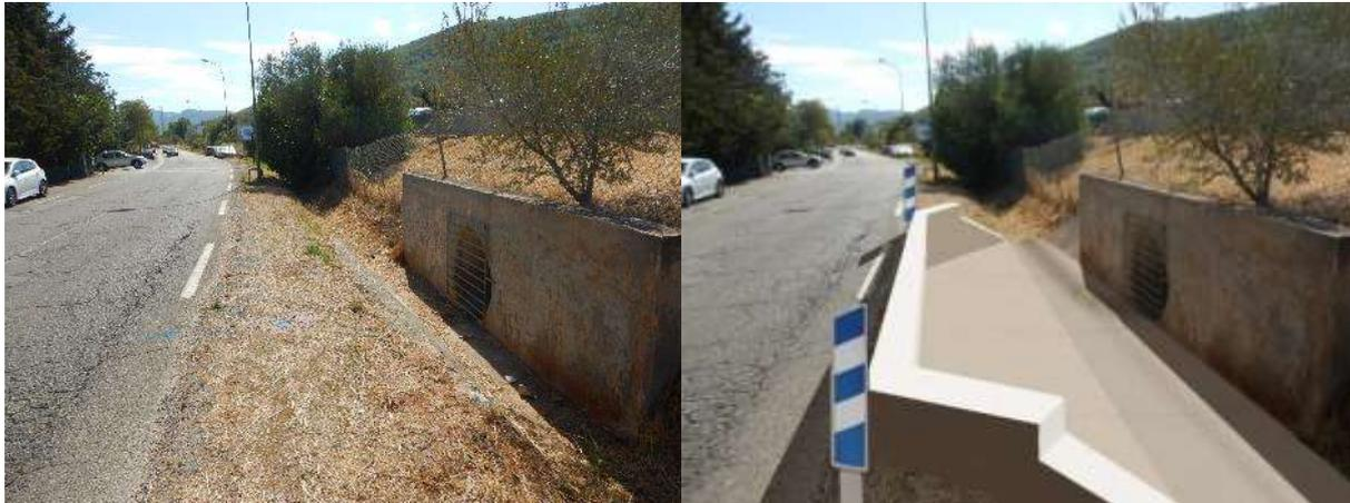
Figure 5. 19 - Photomontage d'aménagement d'un fossé pluvial pour connexion de l'ouvrage de délestage de l'a57
