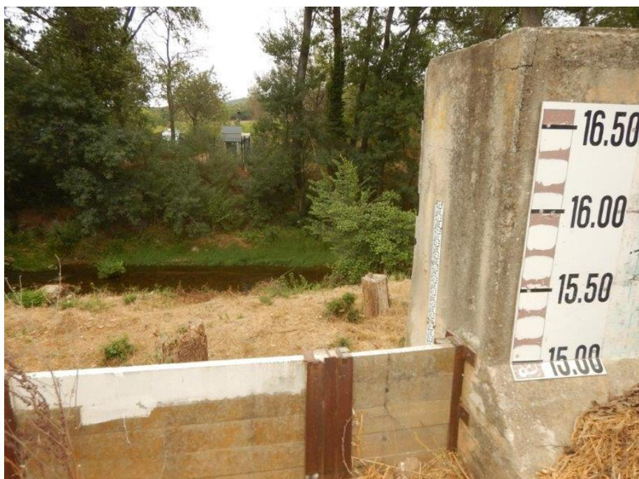
Photo 34 - Echelle limnimétrique du déversoir (photo prise le 01/08/17)
