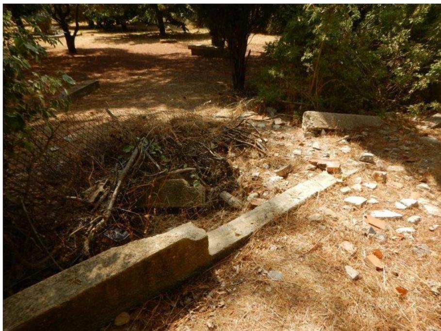
Photo 27 - Clôture et muret détruit par la crue de janvier 2014 (photo prise le 24/08/17)
