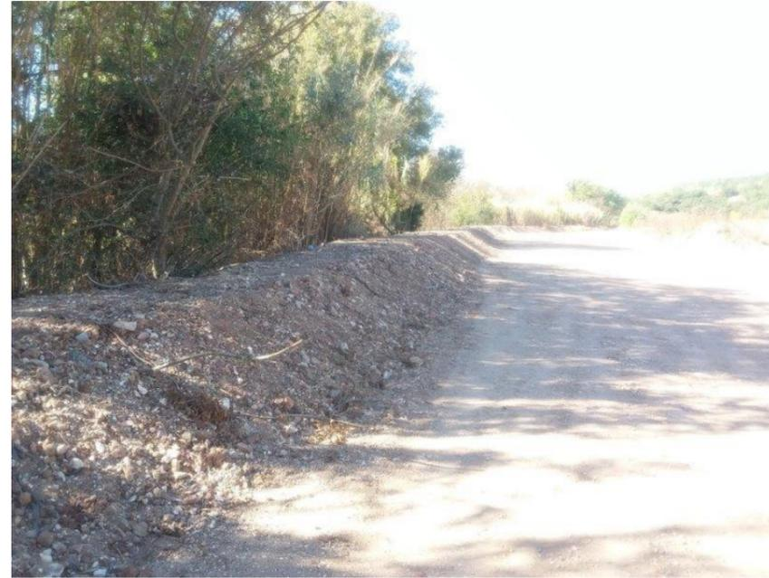
Photo 14 – Ouvrage de protection en terre en rive droite du Réal Collobrier sur la commune de Pierrefeu-du-Var (photo prise le 11/10/17)
