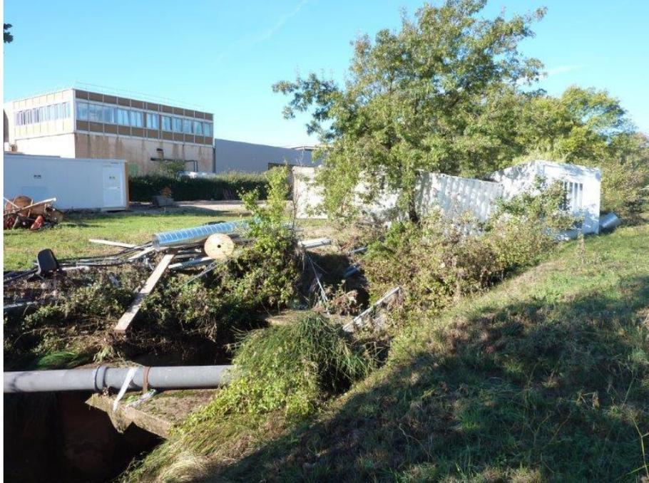
Photo 21 - Embâcles dans le Farembert sur sa partie amont canalisée après la crue d'octobre 2012 (photo de l'AIA Cuers-Pierrefeu)
