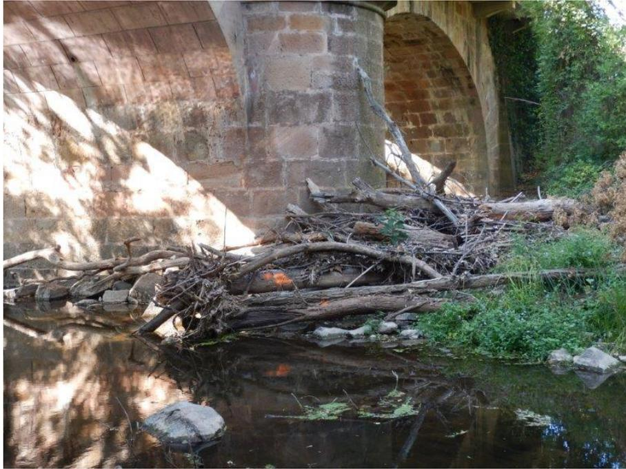
Photo 43 - Embâcles (troncs et branchages) au niveau du franchissement de la RD 29 (photo prise le 12/09/17)
